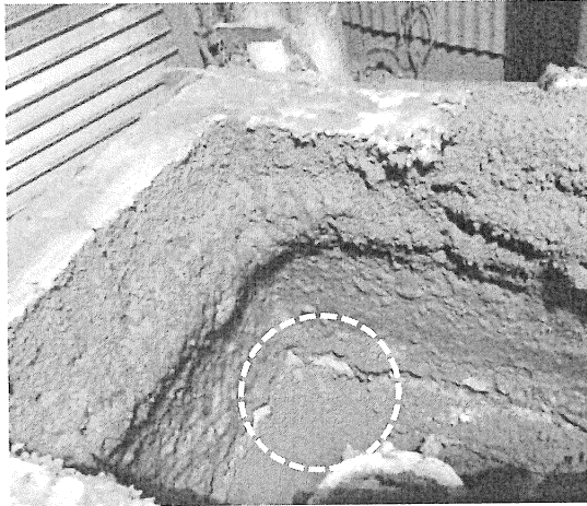
Fig. 2: Sau vài giờ sử dụng vùng phun vẫn không có xi
